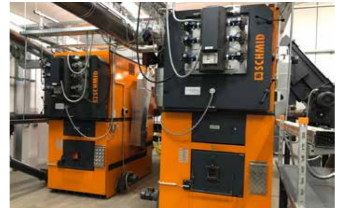
Das aktuellste EDG Referenzprojekt ging im vergangenen Herbst in Gimbsweiler ans Netz. Dort speisen zwei Schmid Feuerungen (360 und 550 kW Leistung) in Kombination mit einer Solarthermieanlage (1'200 m 2 ) ein 4 km langes kommunales Nahwärmenetz mit 86 Abnehmern. Das Heizwerk spart jährlich 460 t CO 2 , was einem Heizöläquivalent von rund 145'000 Litern entspricht.
