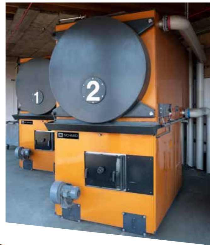
Bisherige Holzfeuerungsanlagen Typ UTSK Jg. 1987
